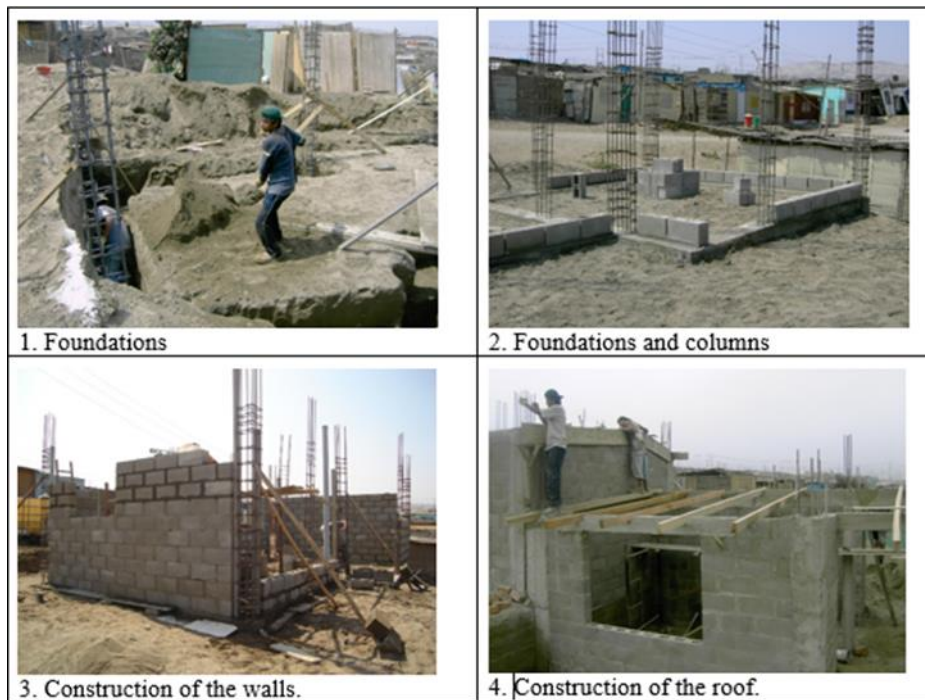
Figura 11. Estructuras de hormigón para que las casas sean resistentes a los terremotos.
